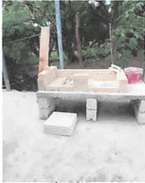
Foto 1: Reparación de estufa rural
