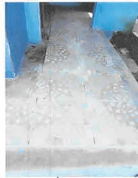
Foto 6: Reparación piso de los sanitarios
