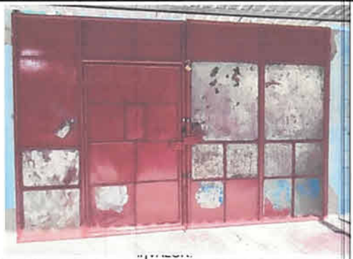
Foto 4: Reparación de columnas de portón
