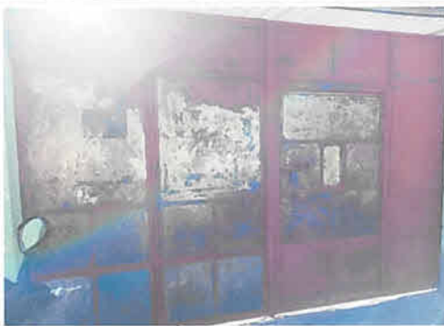
Foto 5: Reparación de portón de ingreso
