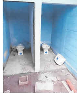
Foto 2: Reparación módulo de sanitarios
