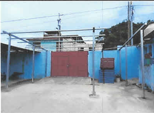
Foto 3: Reparación de techo y ampliación de galera
